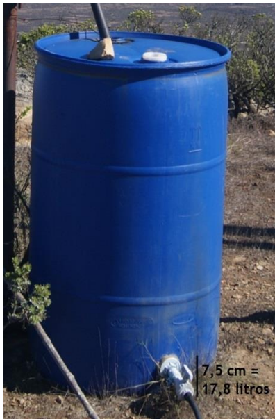
Figure 6. Detalle de la llave que permite vaciar el tanque. Foto de la Fundación Un alto en el Desierto, 2018
